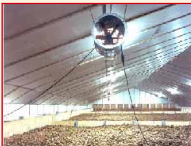
Figuur 29: Ventilator met loshangende kabels van voeding, sturing en voelers (links), roostervloer en houten compartimentering en afsluiting drukkamer (rechts)
