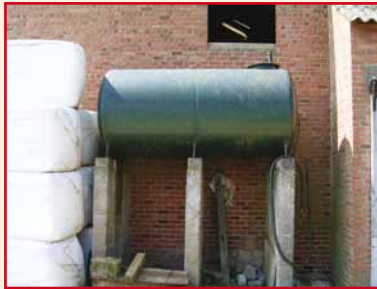
Figuur 31: Aanwezigheid van brandbare materialen in de omgeving van een brander (links) en opslag van voordrooghooibalen naast een niet-gekeurde stookolietank (rechts)
