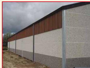
Figuur 12: Een opslagloods met stenen muren (links) of betonnen panelen (rechts)
