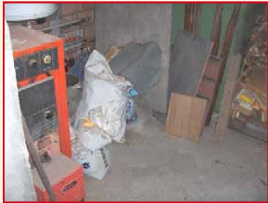
Figuur 31: Aanwezigheid van brandbare materialen in de omgeving van een brander (links) en opslag van voordrooghooibalen naast een niet-gekeurde stookolietank (rechts)
